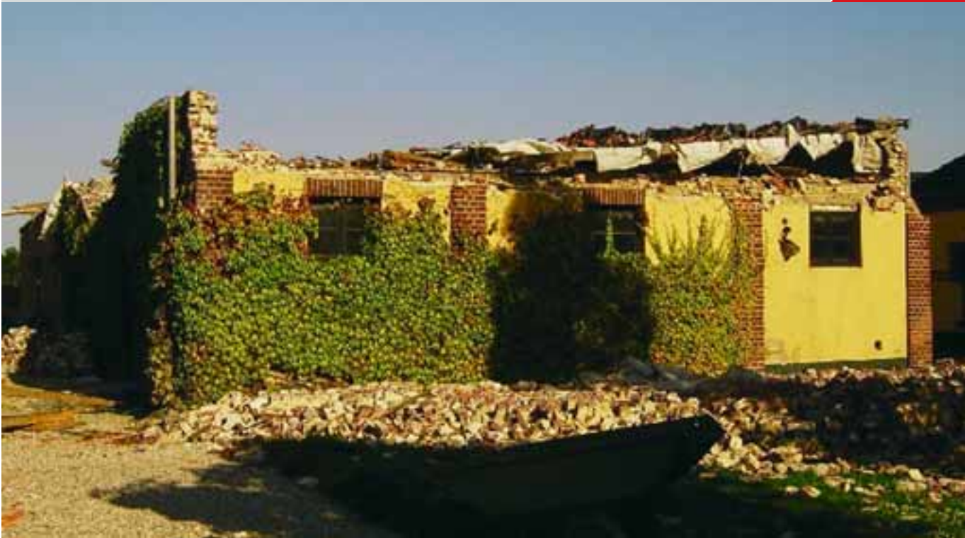
Abbildung 19: Durch einen Tornado am 18.07.2004 total zerstörtes Gebäude in der Nähe von Tönisvorst / Nordrhein-Westfalen (Quelle: T. Sävert; www.naturgewalten.de )
