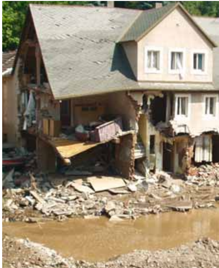
Zerstörtes Haus in Weesenstein an der Müglitz (Quelle: S. Duda, THW)
