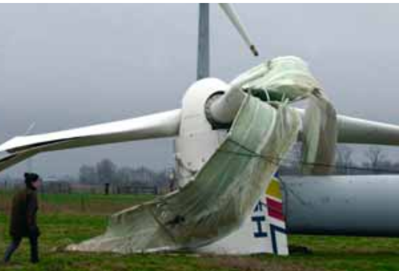
Durch den Sturm JENNIFER zerstörte Windkraftanlage nahe Husum (Quelle: dpa)
