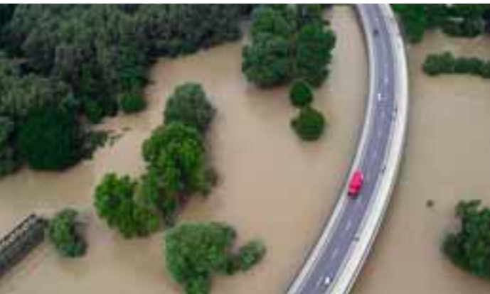
Donaubrücke in der Nähe von Kelheim am 08.08.2000 (Quelle: ddp)
