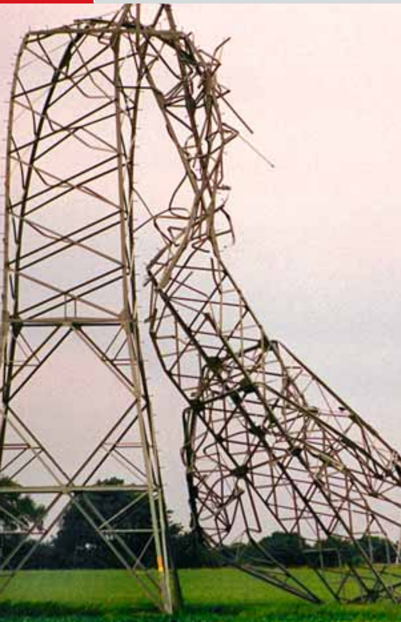
Umgeknickter Strommast in der Nähe von Peine in Niedersachsen nach einem Gewitter am 29.06. 1997 (Quelle: dpa)
